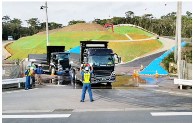
美謝川口を出ようとする土砂搬出のダンプ これが工所用ゲートから入ります
