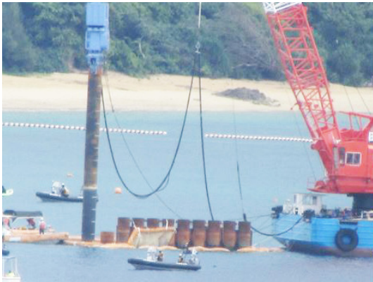
A 護岸（二重鋼管矢板式）で鋼管矢板打設中。K 9 護岸の延長上 8/31 撮影
