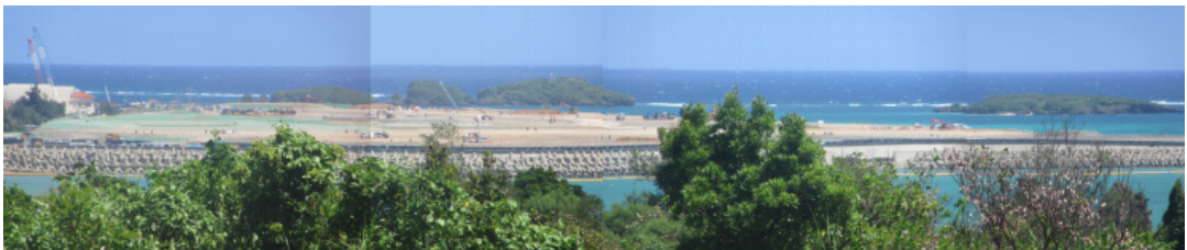
豊原から見た辺野古側の埋め立て状況 会場および陸上から運び入れた埋立用土が積み上げられている 計画では4～5Mほど嵩上げる 9/14撮影
