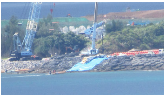
N1 中仕切り護岸築造工事で石材を投下する準備工事をしていると思われる 8/31 撮影
