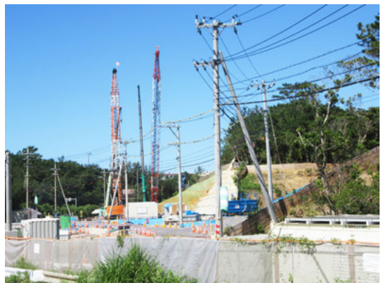
美謝川水路切替のためシートパイルを法尻に打設中
