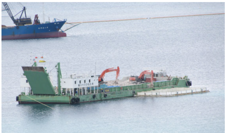
海上作業ヤード場所への石材投入
