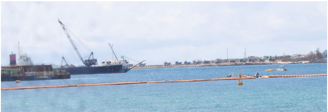
土砂の陸揚げがつづく大浦湾 遠景に並ぶのが K8 護岸上のダンプカー中央右側 (9/19)
