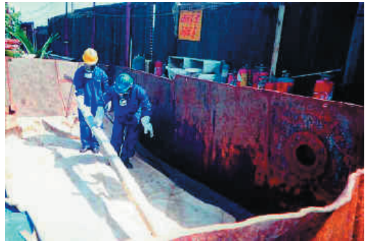
最近のアラン海岸船舶解撤現場でのアスベスト断熱材作業
