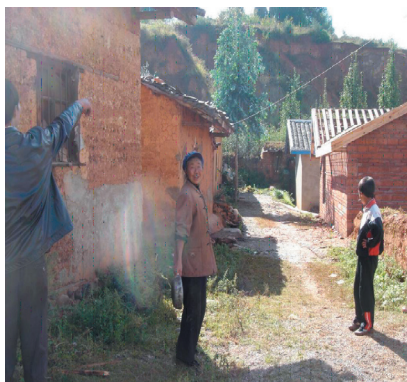
裏山と畑の赤土には青石綿が露出している
