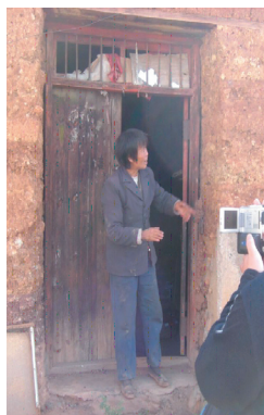
家の壁には青石綿が含まれている
