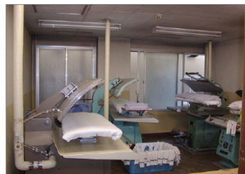
大病院のリネン室。すぐ隣に熱源供給のための石綿吹きつけされたボイラー室がありました。吹きつけられた石綿は自然劣化や損傷により繊維が飛散した可能性があり、扉が開け放たれていた場合にはこの部屋にも繊維が飛散してきた可能性も否定できません。
