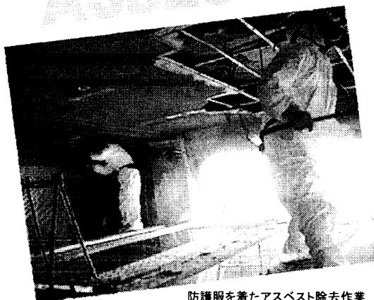
防護服を着たアスベスト除去作業
