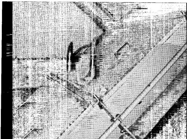
破碎されたごみを搬送するコンベアの途中と、ごみが選別されて溜められる選別物貯留ホッパーにも、温度を感じて散水する設備を増設した。
