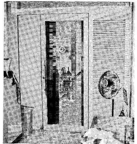
(写真9) ガラス扉に改善された扉
