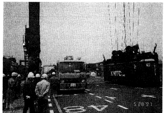
コンテナをヤードにおろす。
