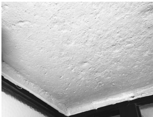
封じ込め工事された天井
