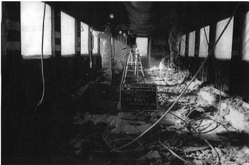
J R車輛石綿除去作業（裁判書証より）
