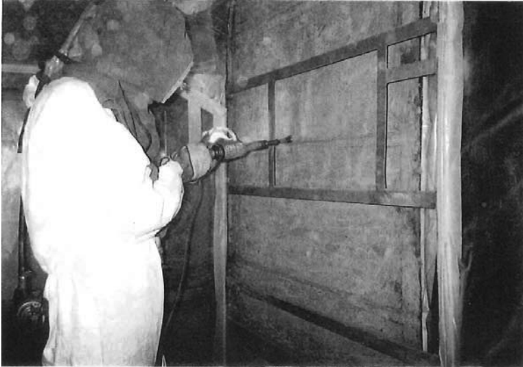
J R 車輛石綿除去作業（裁判書証より）
