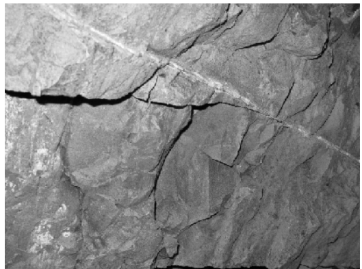
白く走る石綿の層
