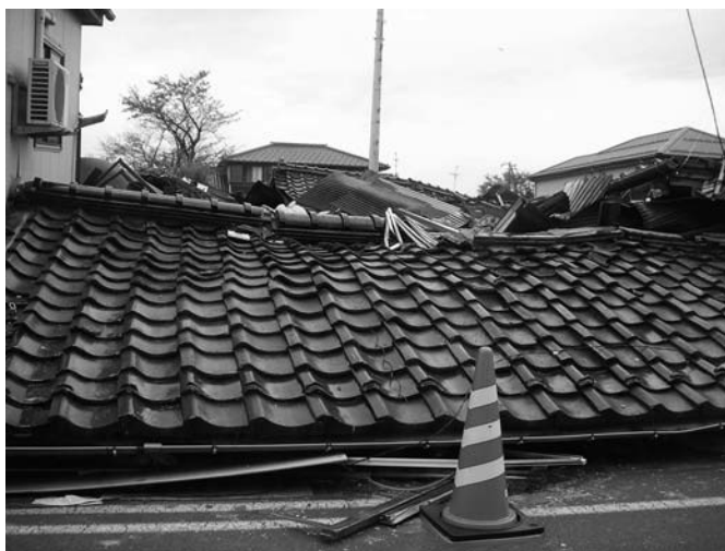
倒壊した家屋
