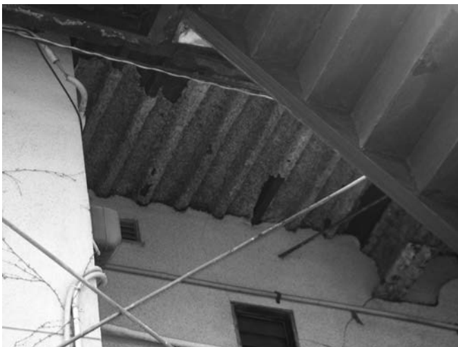
吹きつけが剥がれ落ち、鉄板が見える天井
